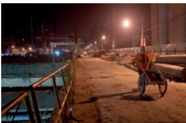
Le chantier du métro de la ligne 10 devrait s'achever en 2009. Arthur Frayer/CUEJ
